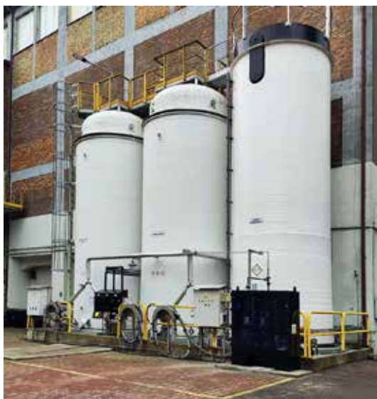
Przykładowy kompletny węzeł magazynowania i dozowania.
